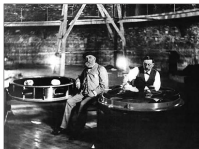
Clark et son assistant avec un objectif de lunette astronomique de 1 m de diamètre...
